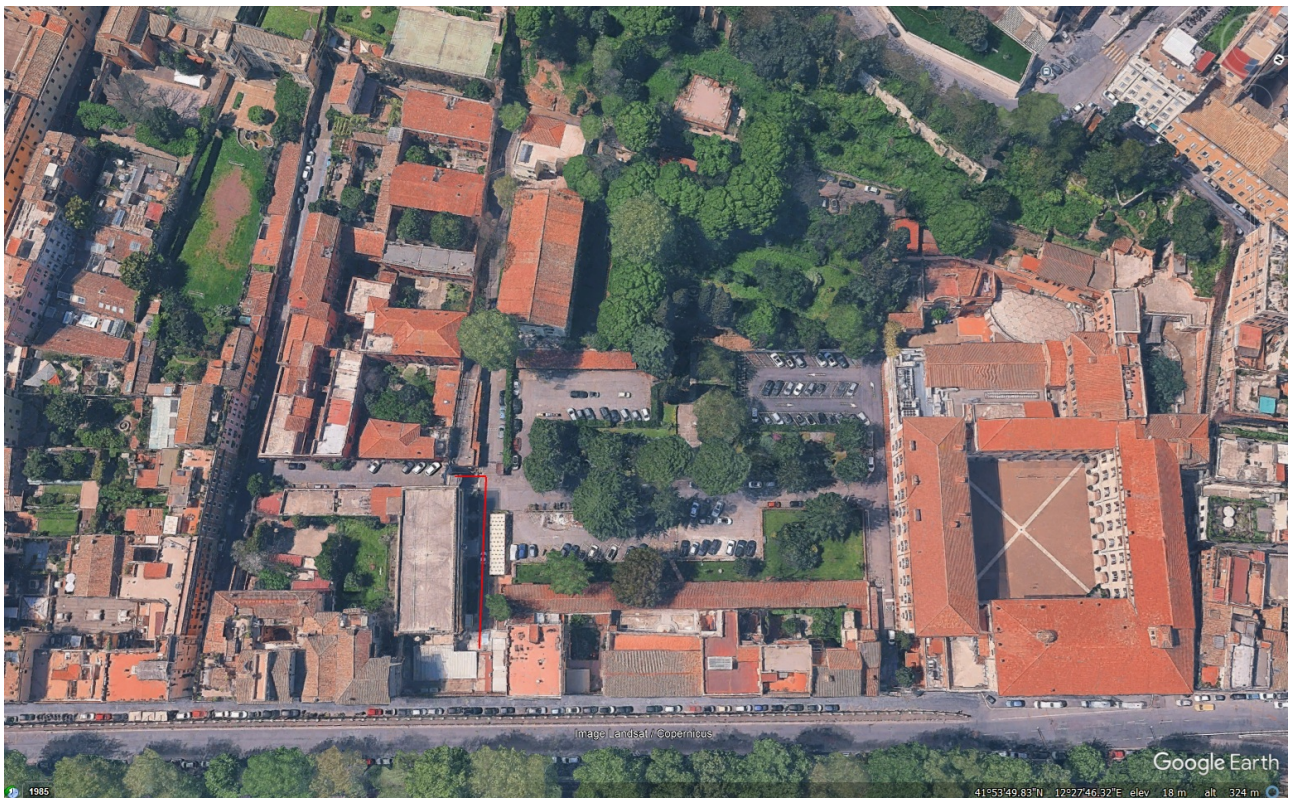
Figura 1 - Vista del comprensorio della Caserma Lungara
