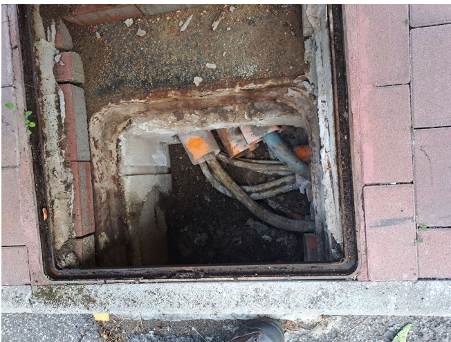
FIG. 7 – DISTRIBUZIONE PRINCIPALE INTERRATA STATO ATTUALE
