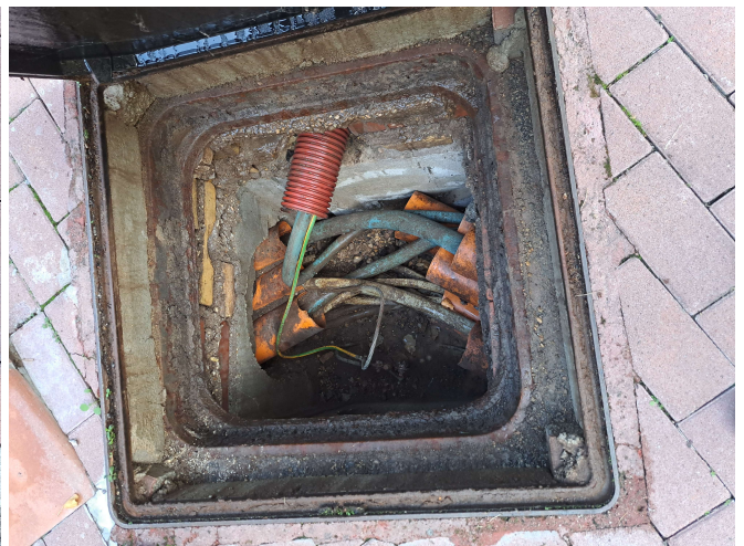
FIG. 7 – DISTRIBUZIONE PRINCIPALE INTERRATA STATO ATTUALE
