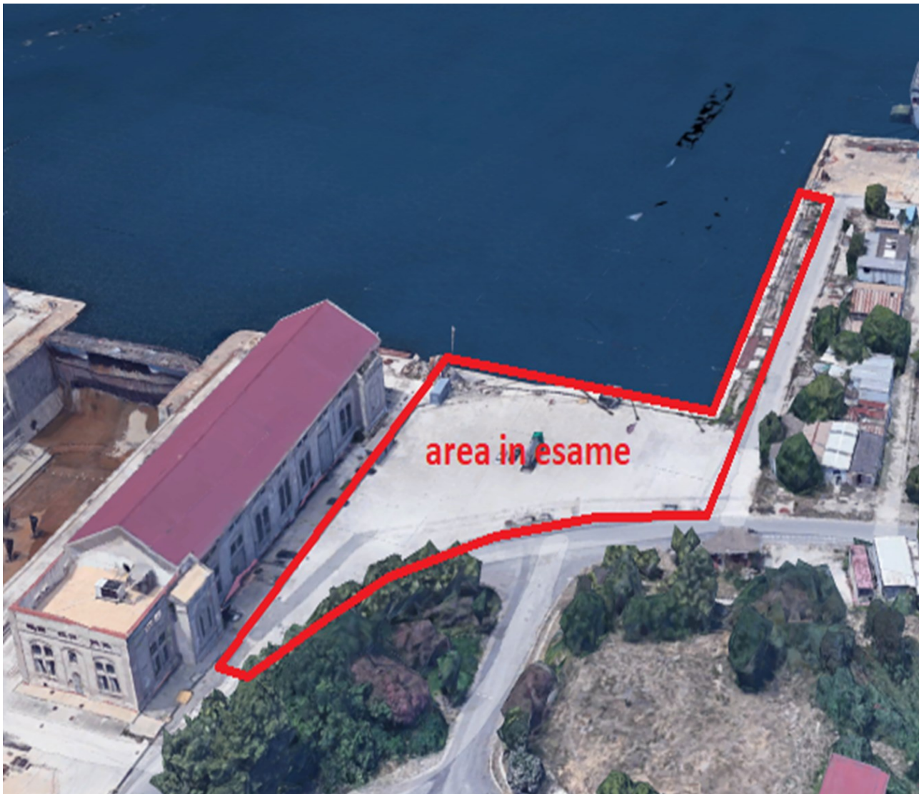
Figura 1 (Base Navale di Taranto – area lavori)
