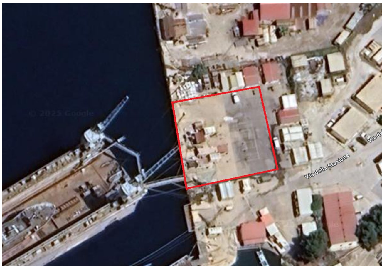
Figura 2 (Base Navale di Augusta – Sito lavori)
