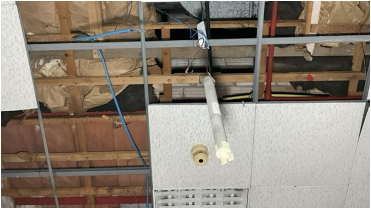
Foto 12 - Dettaglio del controsoffitto
