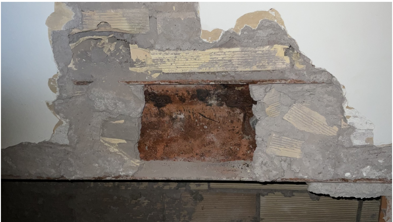
Trave in acciaio P1° a quota + 1 c.a. dal calpestio (presumibilmente coronamento del boccascena)
