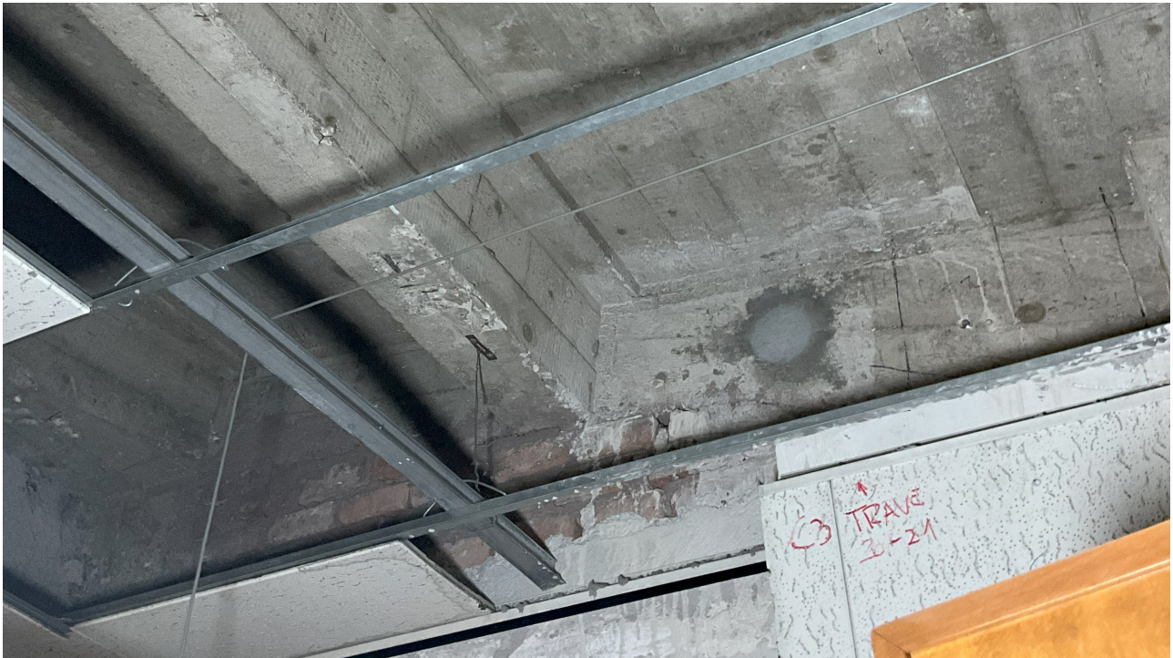
Solaio in c.a. Q.ta + 4.10 ( presumibilmente ex balconata)
