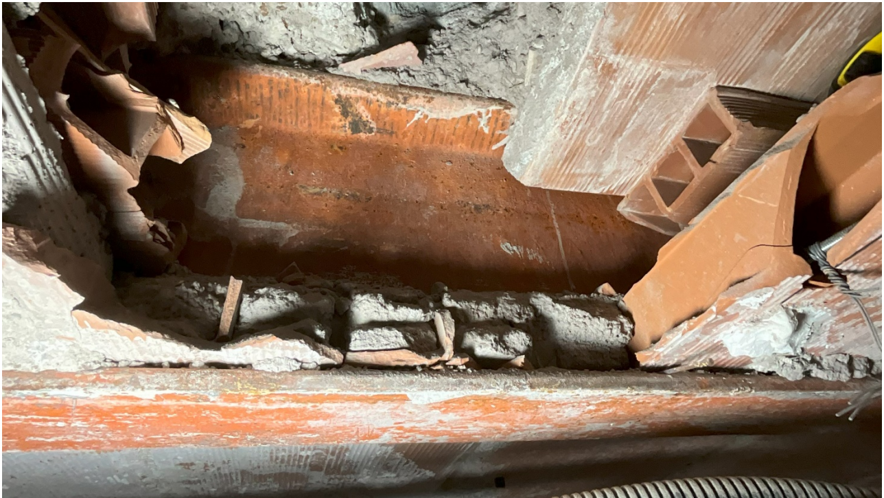
Trave solaio di copertura
