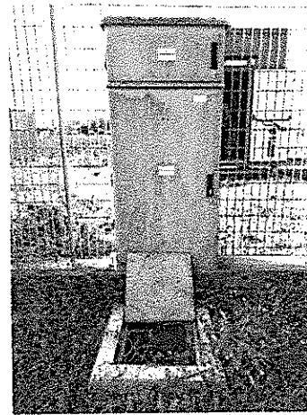
Armadio esterno Q.E principale
