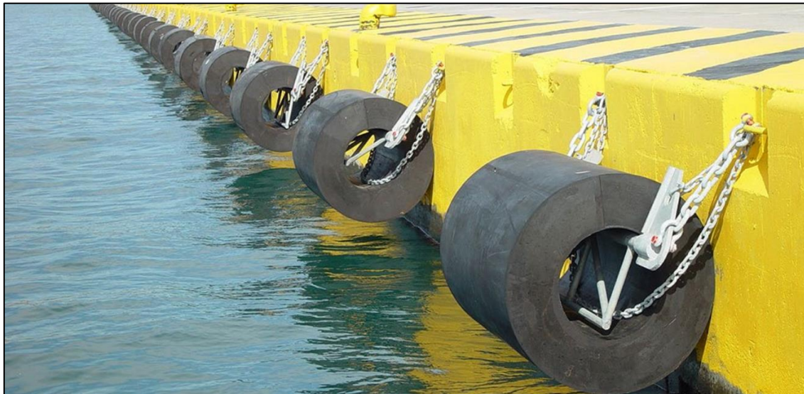
Figura 8.5 - Esempio di impiego di parabordi del tipo cilindrico
