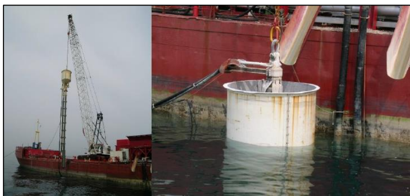
Figura 8.69 - Metodo “Wet Bottom-Feed” – Particolare mezzi navali e attrezzature impiegate nei Lavori di prolungamento della diga foranea antistante la Riva Traiana a Trieste
