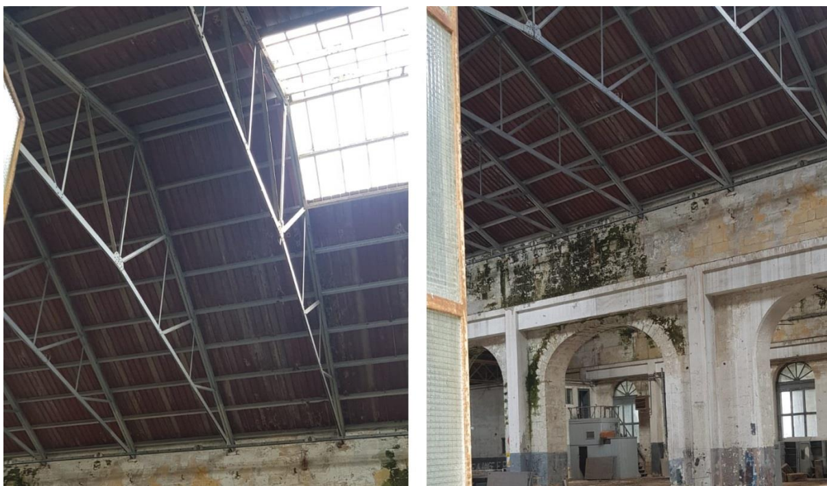
Figura 22 - Tavolato ligneo e capriate di copertura Settore Scafi
