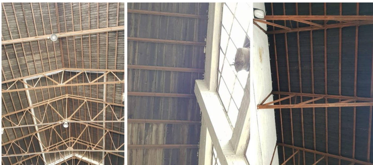
Figura 21 - Tavolato ligneo e capriate di copertura Forni e Fabbri
