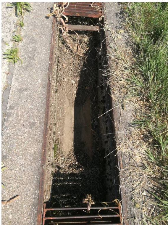
Foto 10 - Cordolo perimetrale con canalina prefabbricata per la raccolta delle acque meteoriche
