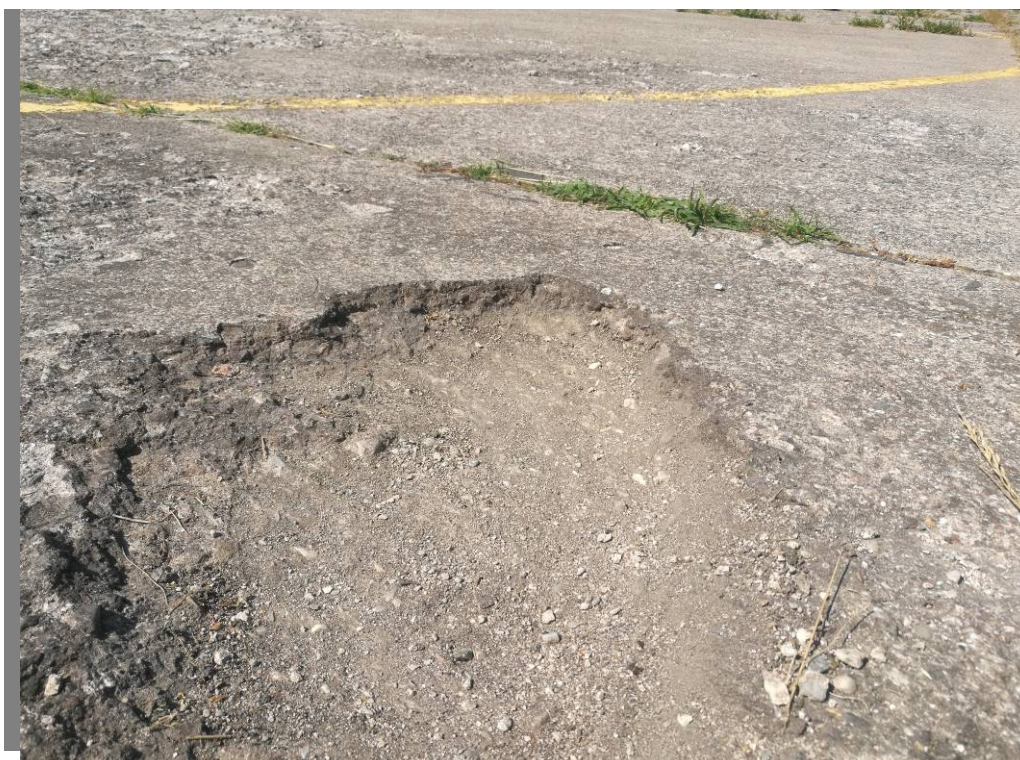
Foto 8 – Stato di usura della pavimentazione in cls
