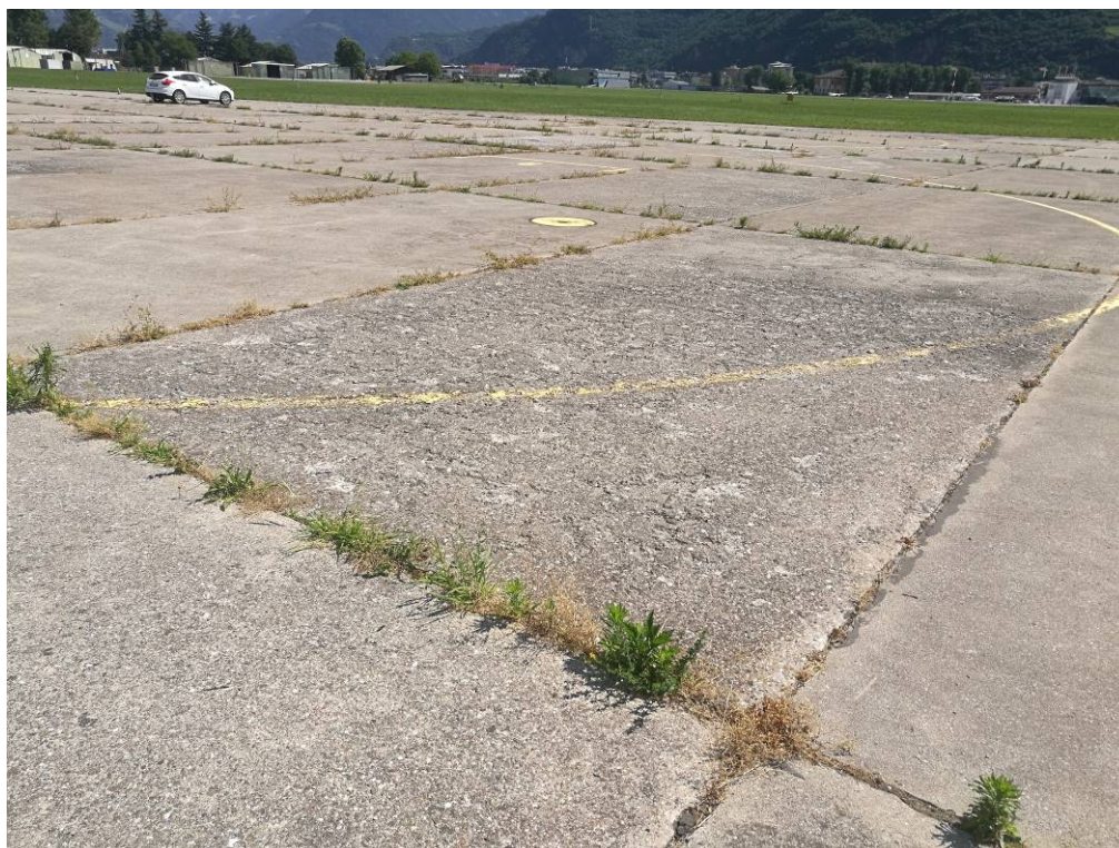
Foto 7 - Pavimentazione in lastroni di cls ammalorato
