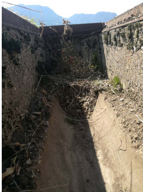
Foto 10 - Cordolo perimetrale con canalina prefabbricata per la raccolta delle acque meteoriche
