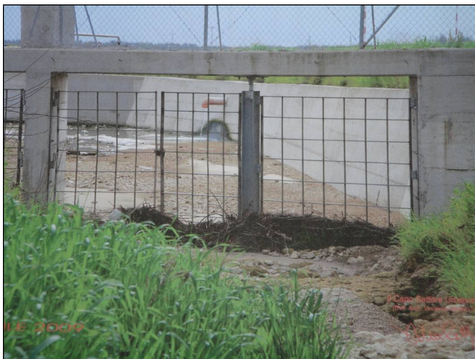
Foto n. 11 - Intasamento della griglia in corrispondenza della sezione del Bacino B1 in occasione della piena del dicembre 2008 – Fonte Comune di Grottaglie per gentile concessione MARISTAER
