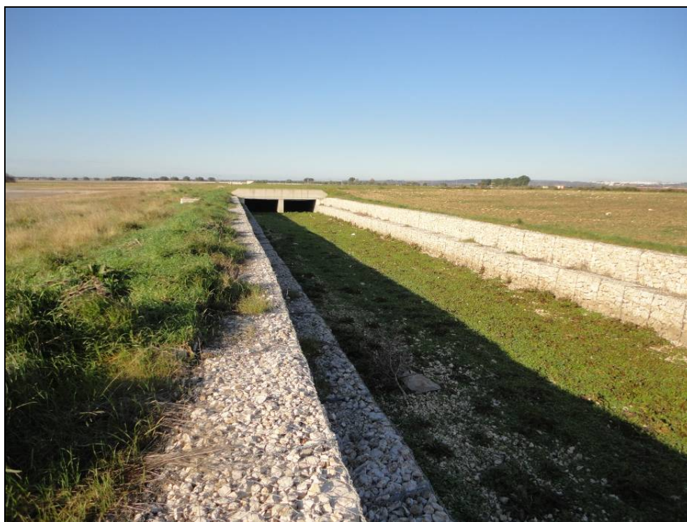
Foto n. 2 – Veduta della sezione di ingresso in galleria al di sotto della pista aeroportuale del Vallone Fullonese
