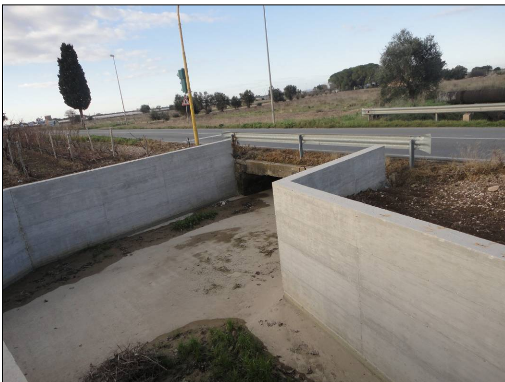
Foto n. 3 – Veduta del tombino di raccolta in c.a. a monte della sezione considerata
