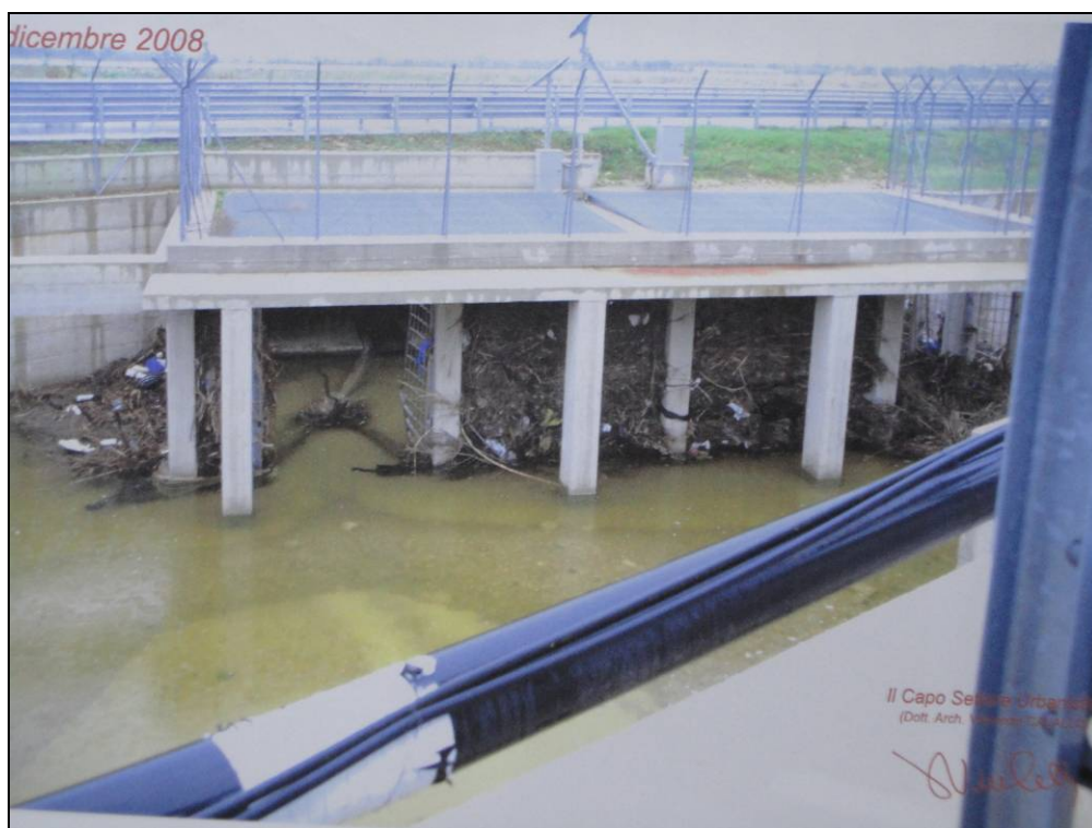
Foto n. 12 – Intasamento della griglia in corrispondenza della sezione del Bacino B3 in occasione della piena del dicembre 2008 – Fonte Comune di Grottaglie per gentile concessione MARISTAER
