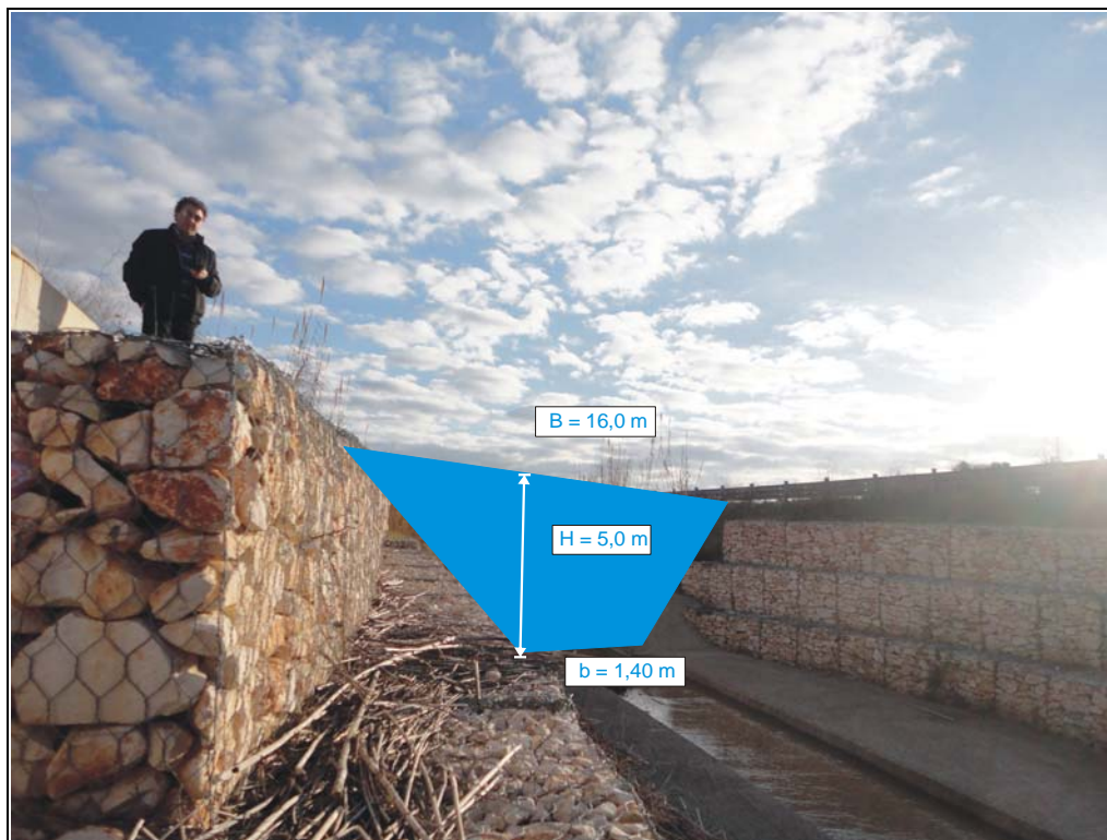
Foto n. 10 – Sezione bacino B3. Lo schema raffigurato evidenzia la sua geometria rettangolare.
