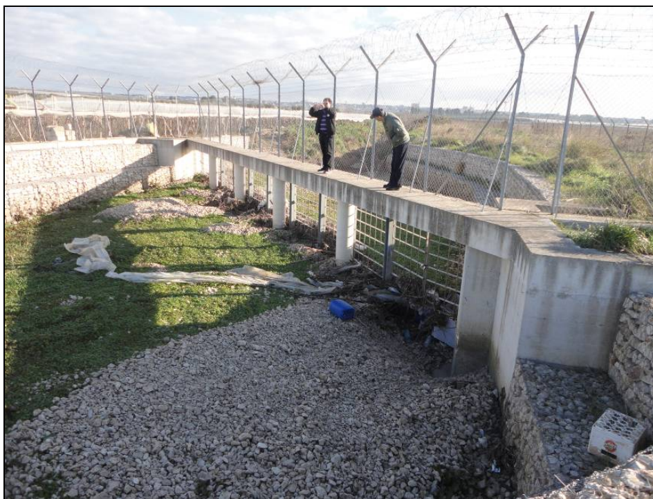
Foto n. 1 – Veduta della sezione in ingresso alla struttura aeroportuale del torrente Vallone Fullonese. Si nota la griglia di protezione
