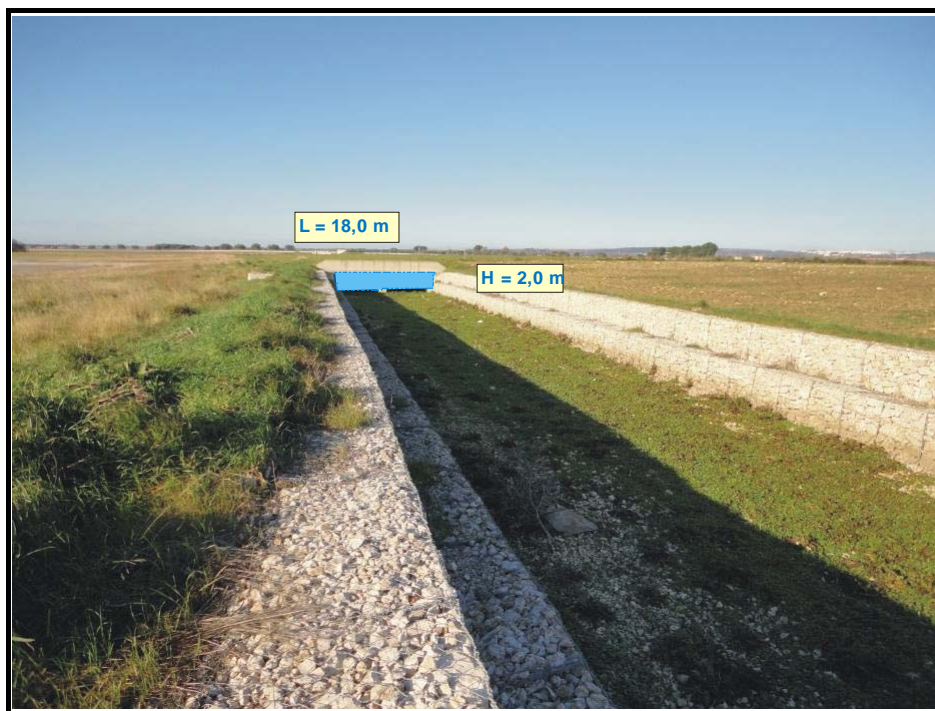
Foto n. 8 – Sezione bacino B1. Lo schema raffigurato evidenzia la sua geometria rettangolare.
