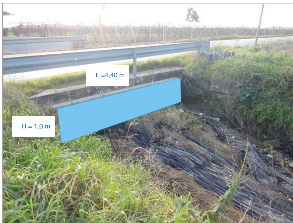
Foto n. 9 – Sezione bacino B2. Lo schema raffigurato evidenzia la sua geometria rettangolare.
