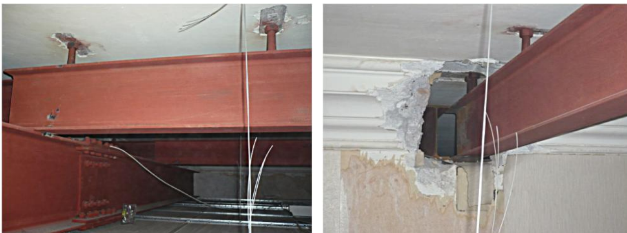
figg. 2.8 e 2. 9 - Consolidamento solaio saggio E8
