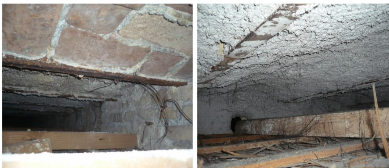
figg. 2.1 e 2.2 - Vista generale tipologia di solaio e camera a canne (5° piano)
