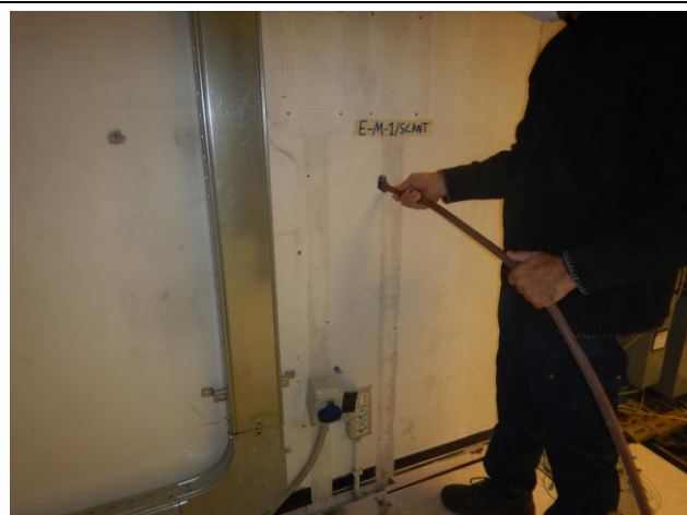
Pulitura del foro mediante aspiratore
