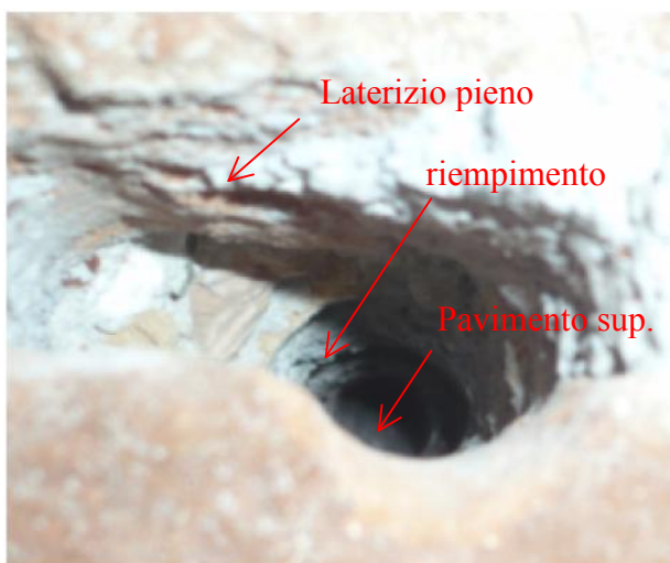
fig. 2.5 - Foro per rilievo stratigrafia
