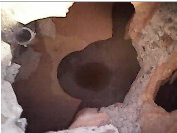
Fodera in mattoni forati e camera d'aria
