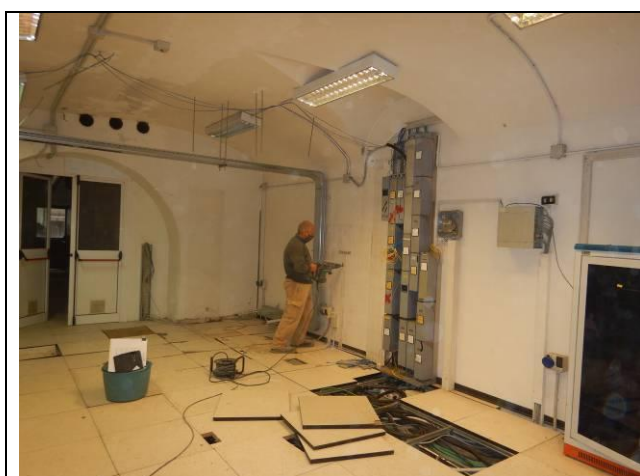
Foratura mediante trapano a percussione
