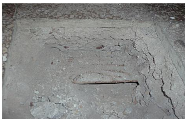
fig. 2.7 - Saggio eseguito a pavimento – stratigrafia superiore
