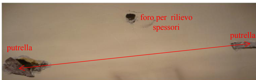
fig. 2.3 - Tipologia di saggio a soffitto
