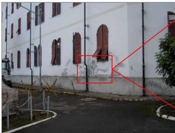
Degrado degli intonaci di facciata.
