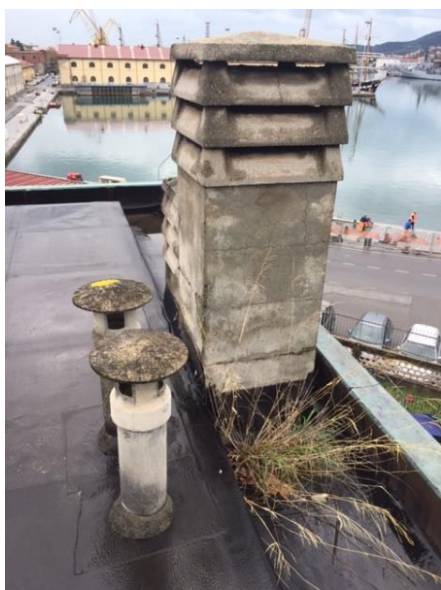
Figura 6: Solaio di copertura - Discontinuità della guaina bituminosa impermeabilizzante
