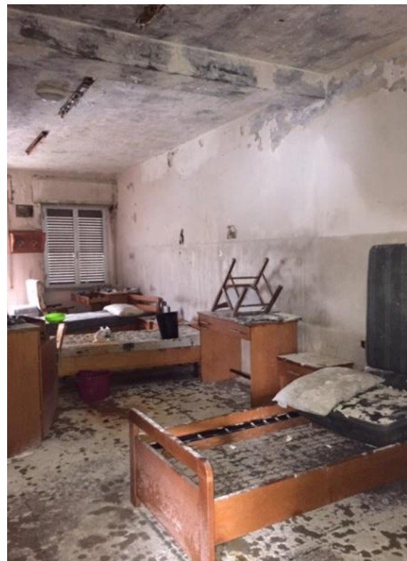
Figura 5: Alloggio 2°Piano - Infiltrazioni e distacchi di intonaco per le infiltrazioni attraverso il solaio di copertura
