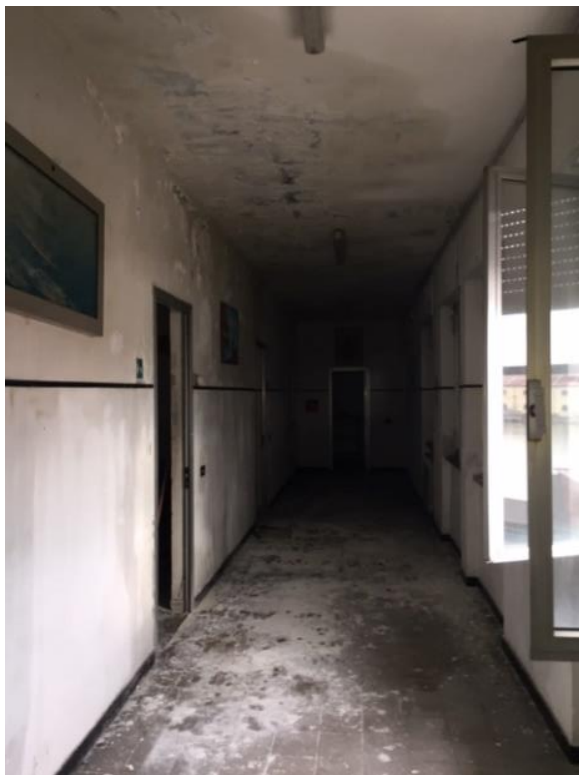
Figura 4: Corridoio di accesso alle camere del 2°Piano - Infiltrazioni e distacchi di intonaco per le infiltrazioni attraverso il solaio di copertura
