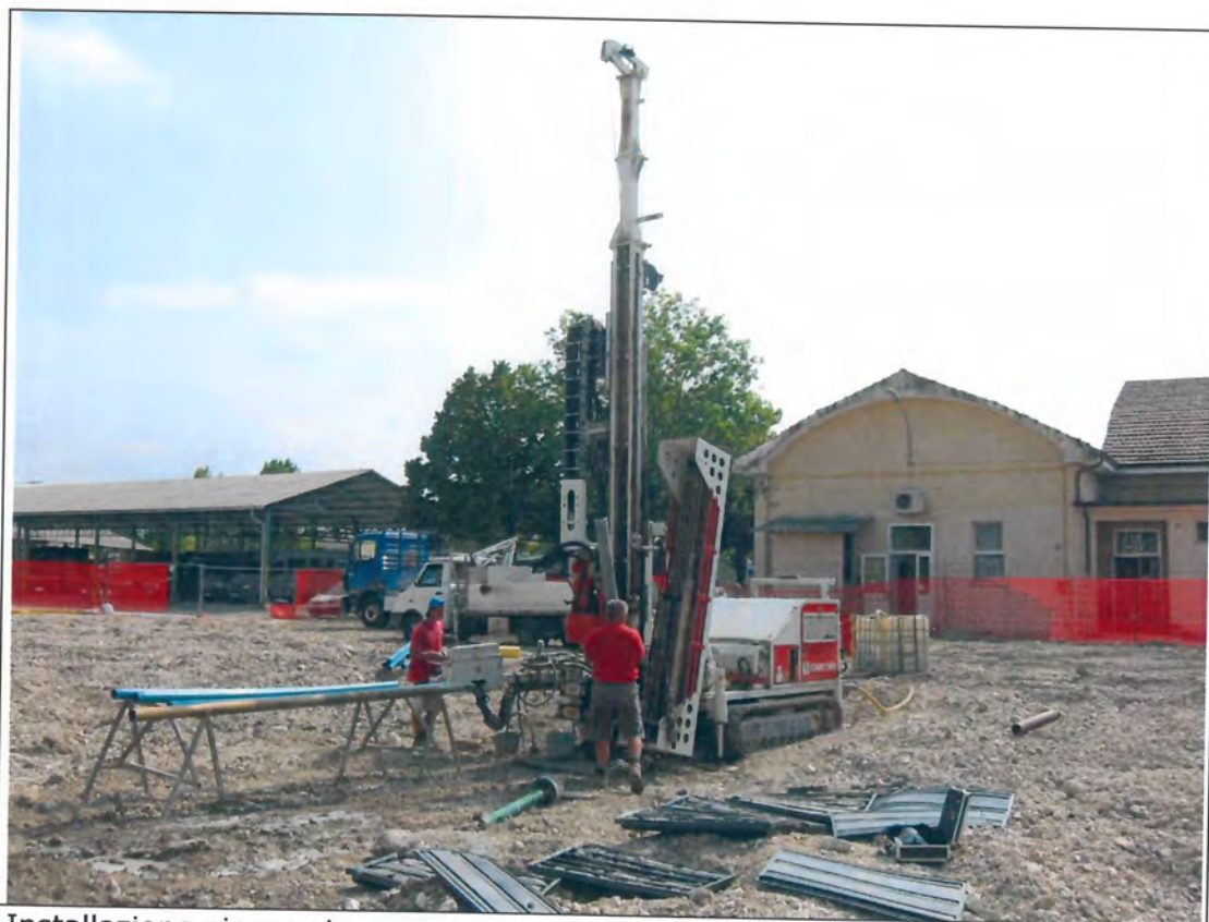
Installazione piezometro
