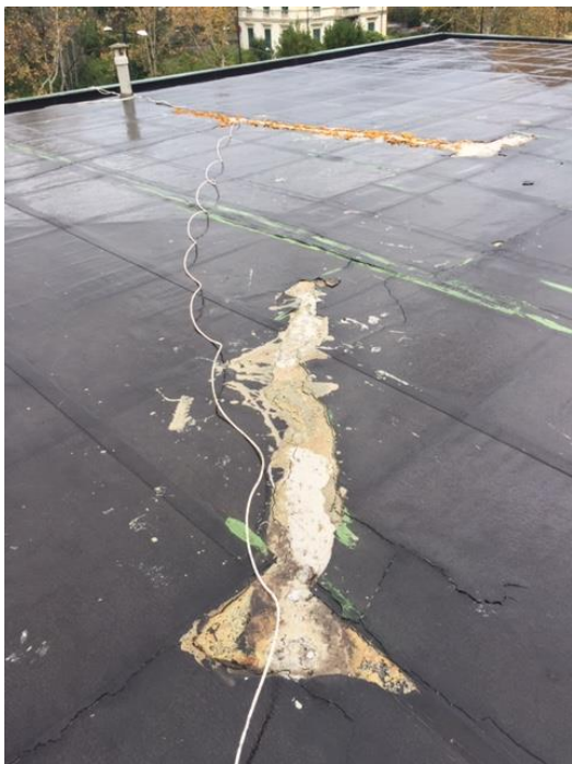
Figura 6: Solaio di copertura - Discontinuità della guaina bituminosa impermeabilizzante
