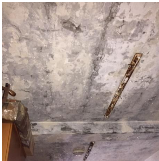
Figura 7: Solaio di copertura - Infiltrazioni e distacchi di intonaco
