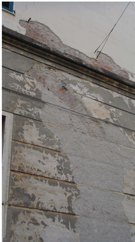
Particolare intonaco degradato
