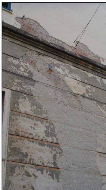
Particolare intonaco degradato
