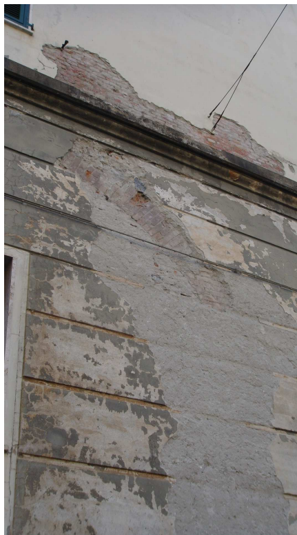
Particolare intonaco degradato
