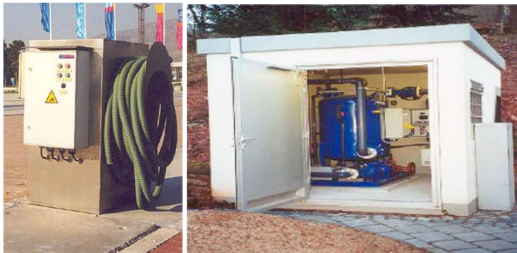
Figure 24 - Colonnina e Stazione del vuoto per scarico reflui in banchina
