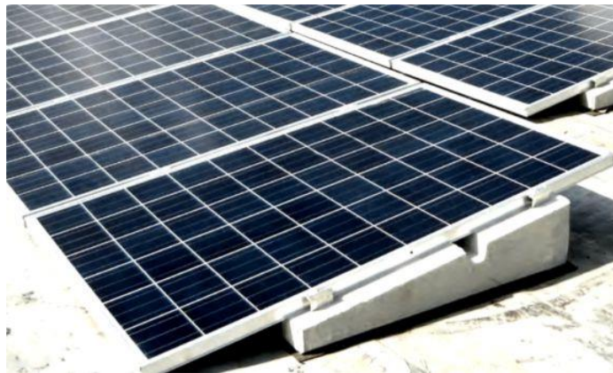
Figura 7 Esempio di installazione di pannelli su tetto piano con zavorra di cemento senza forature del manto di copertura
