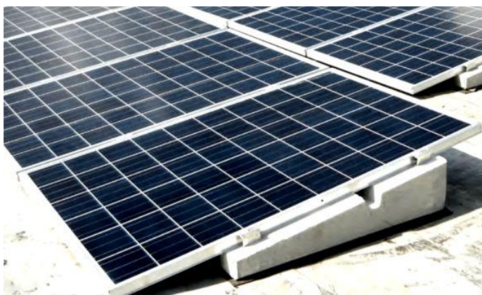
Figura 16 Esempio di installazione di pannelli su tetto piano con zavorra di cemento senza forature del manto di copertura
