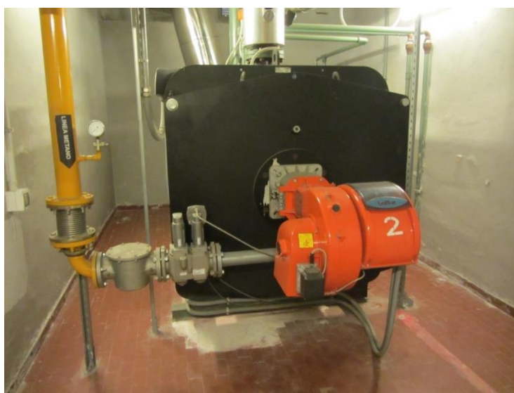
Figura 3 Caldaia Baltur Startre 1400
