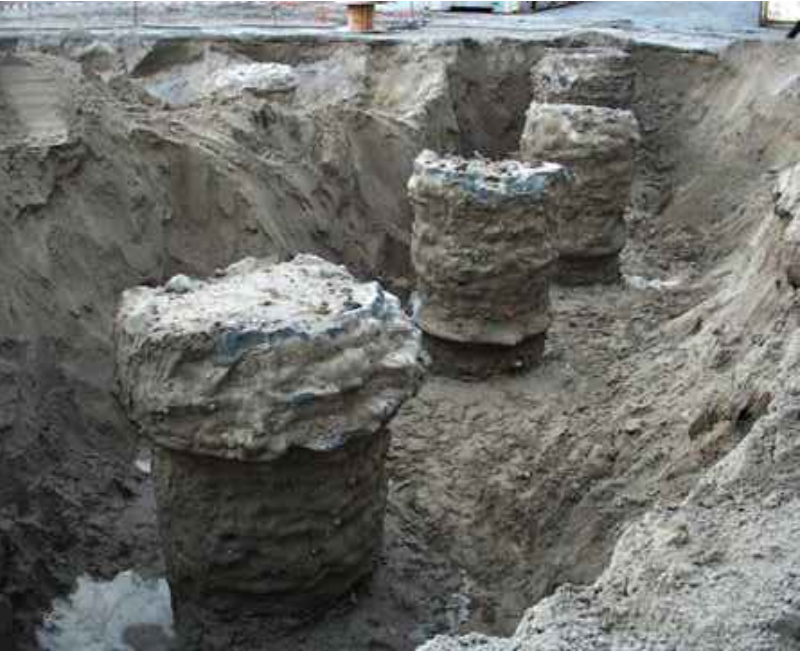
Esempio di colonne jet grouting
