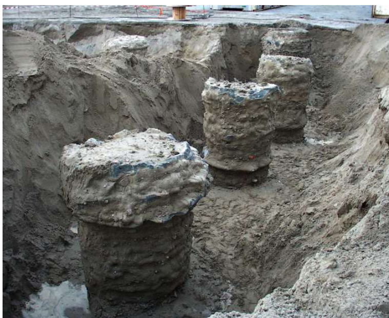
Figura 31 Colonne di consolidamento jet-grouting
