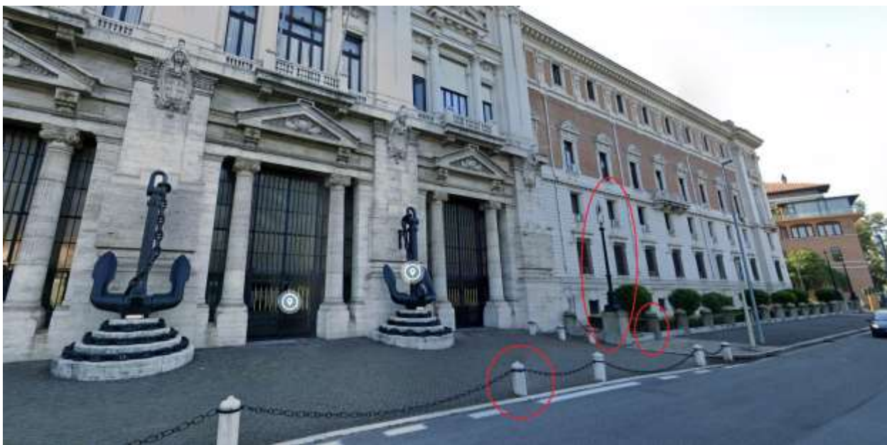
Elementi costituenti la recinzione esterna sul lato Lungotevere delle Navi
