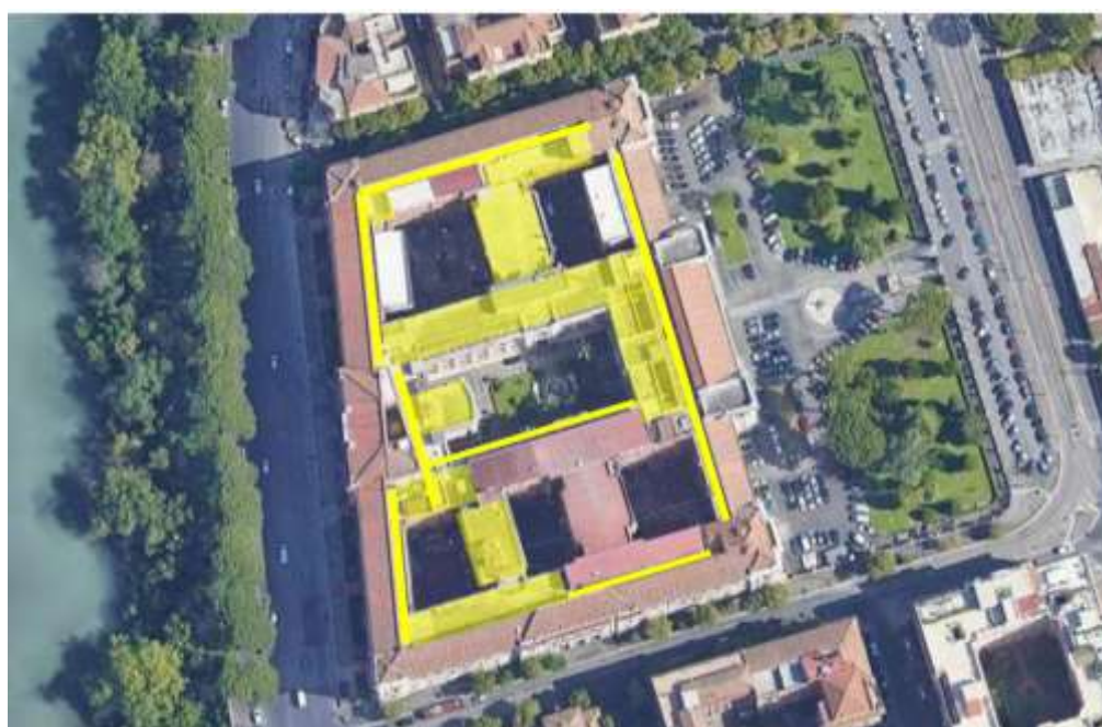
Copertura piana a terrazzo
