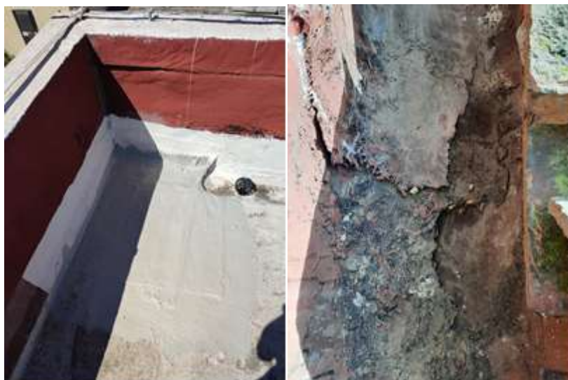
Sovrapposizioni di strati impermeabilizzanti
