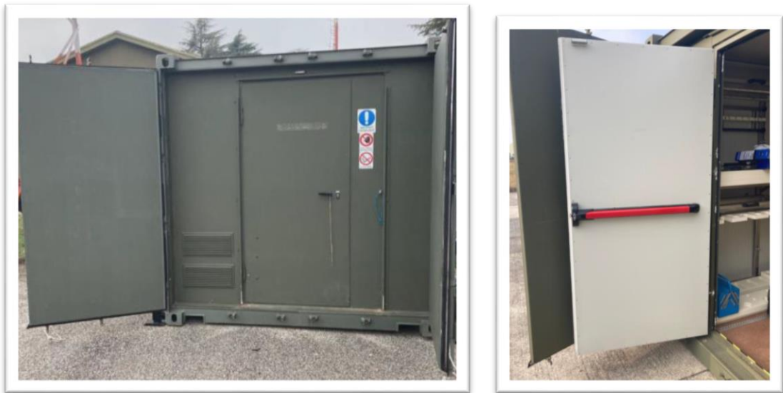
Fig. 4 immagine, a titolo esemplificativo, della porta con paratia interna (aperto/chiuso)
