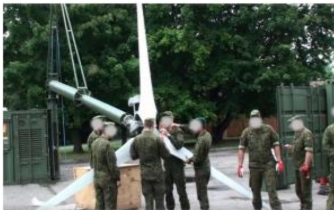
Fig. 28 – Assemblaggio sistema eolico in sito militare
