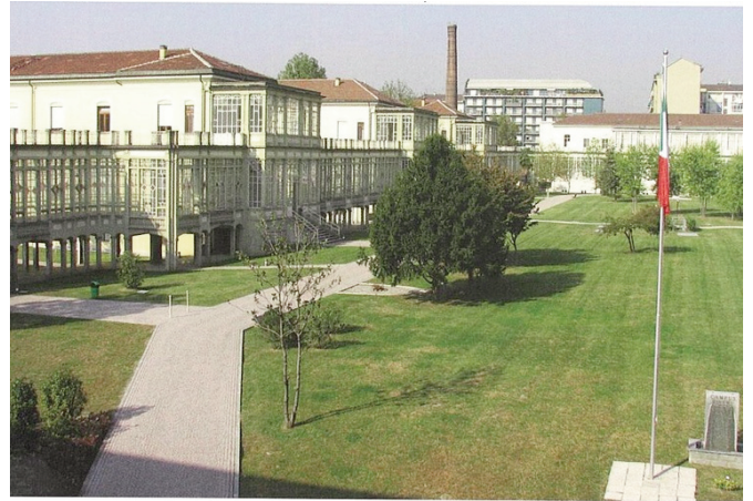
Fig. 7 - Particolare del corridoio liberty che consente il collegamento tra i padiglioni disposti intorno al giardino cortile centrale.
