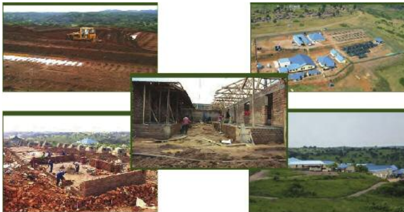
Fig. 4 - Immagini delle varie fasi di costruzione del "Bihanga Training Camp".
