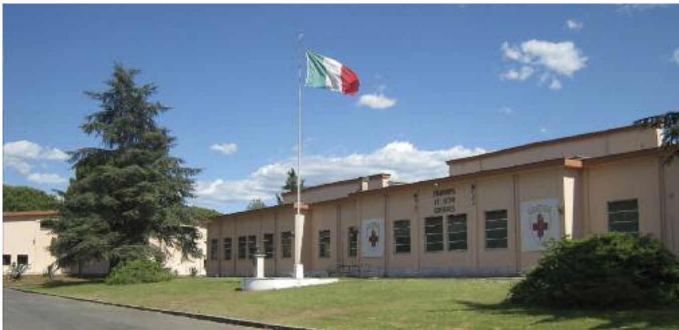
Fig. 8 - Scuola di Sanità e Veterinaria Militare – Piazzale Enrico Reginato.
