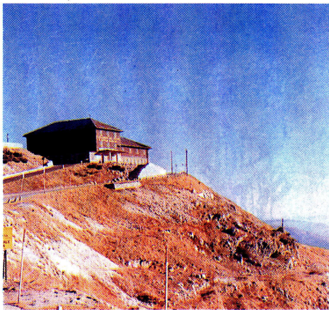
Casa "Armata del Grappa"
