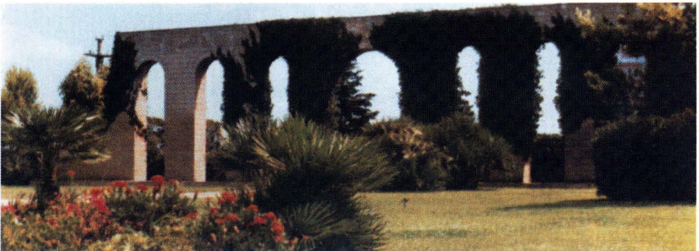
Il tronco dell'Acquedotto romano
