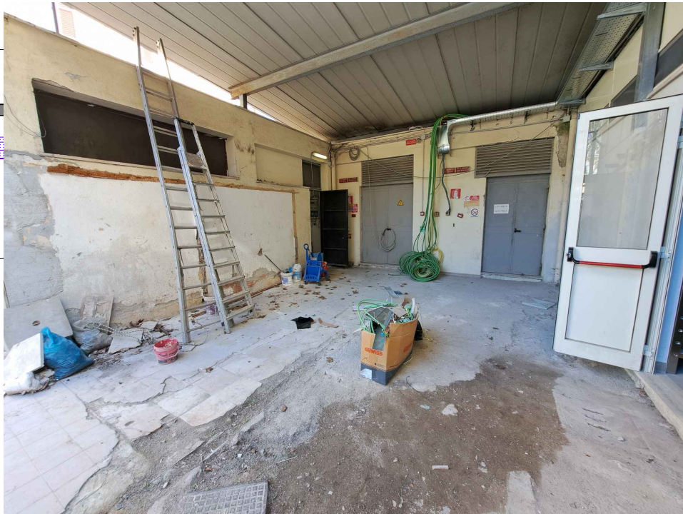
LOCALE CABINA - VISTA ESTERNA
