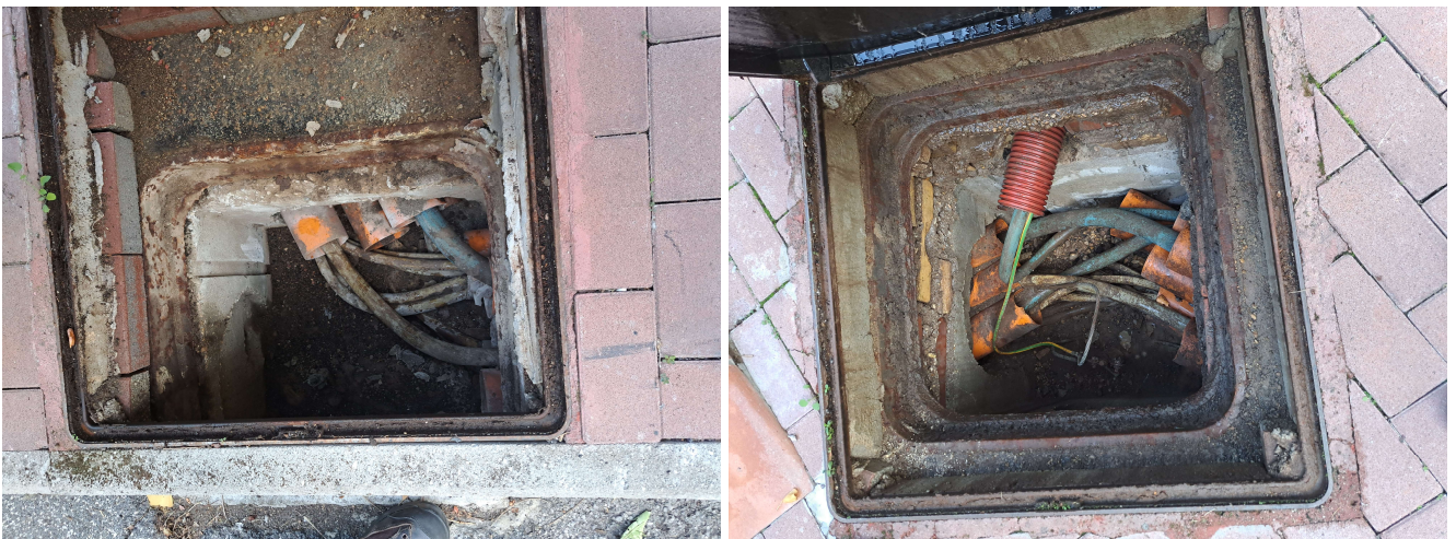
FIG. 7 – DISTRIBUZIONE PRINCIPALE INTERRATA STATO ATTUALE
