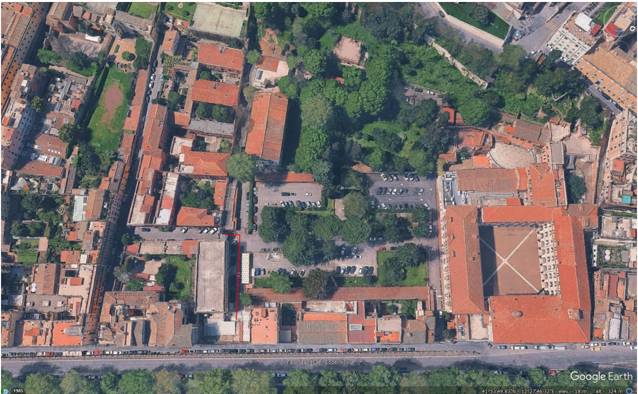
Figura 1 - Vista del comprensorio della Caserma Lungara
