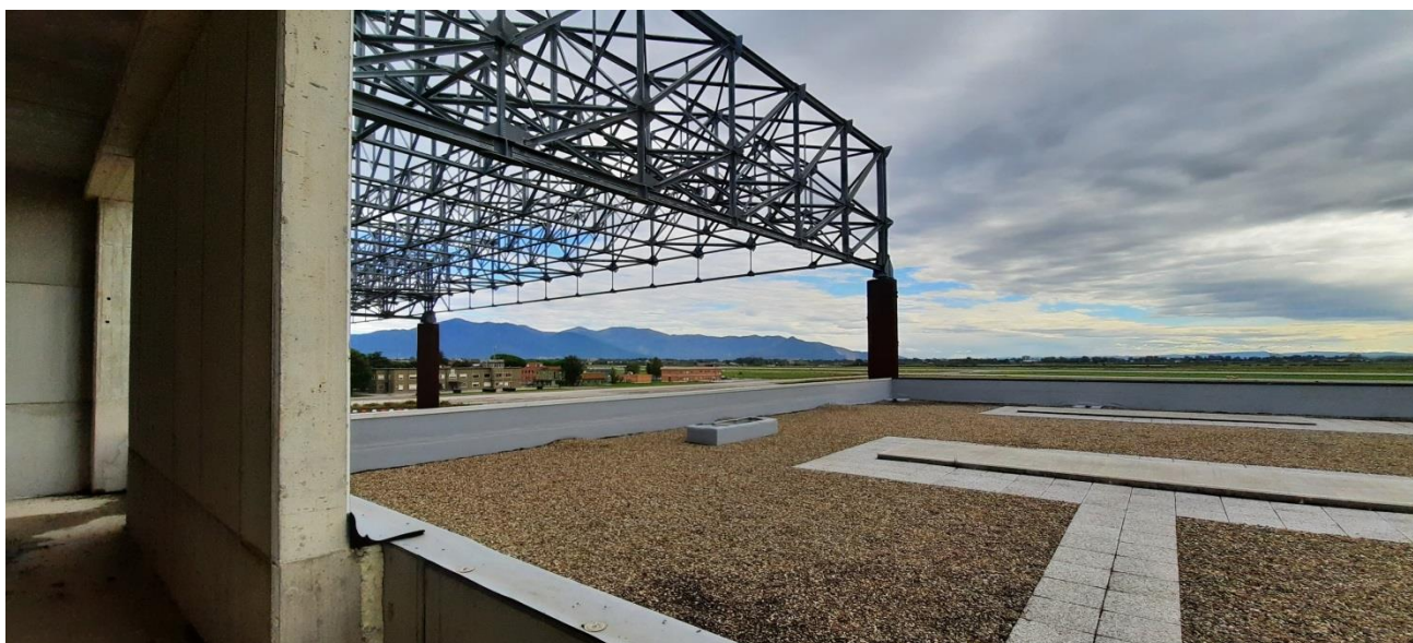
Due immagini della copertura delle officine; si notano tutte le lavorazioni già realizzate, compresi i basamenti degli impianti, la finitura della copertura, e le scossaline dei parapetti perimetrali
