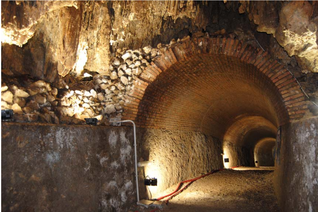
Particolare della volta
