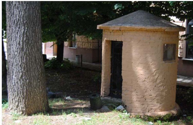
Uscita secondaria e sistema di ventilazione
