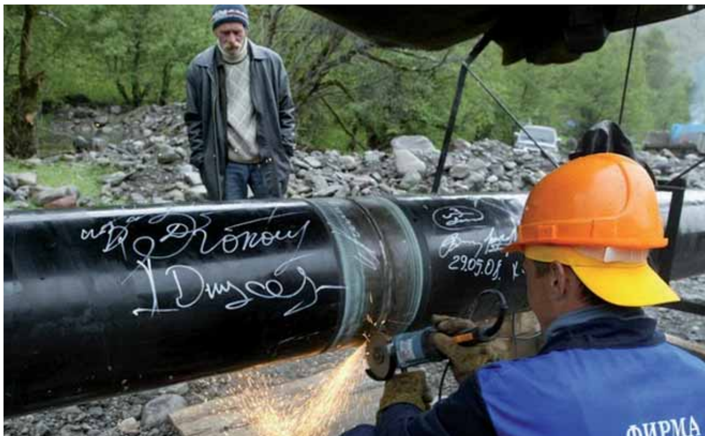
Lavori su un tratto del gasdotto Dzuarikau-Tskhinval.
