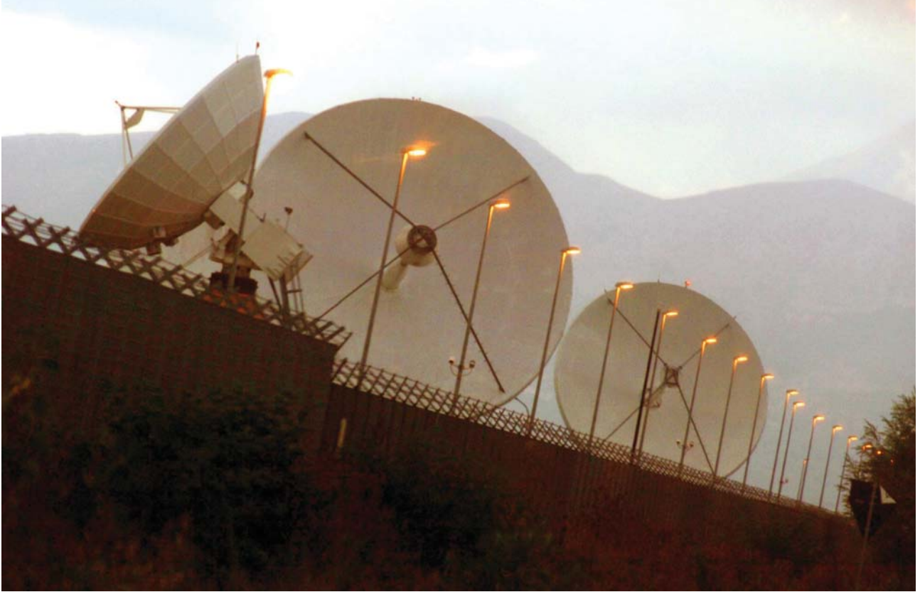
Piana del fucino (AQ) le antenne paraboliche del centro telespazio. Foto di © Danilo Balducci Ag. Sintesi
