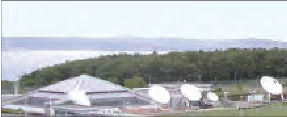
SICRAL - Vigna di Valle Control Centre
