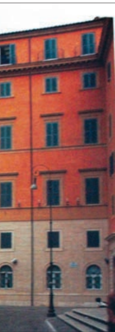
Edificio adibito a Biblioteca del Senato
